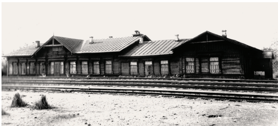
Железнодорожная станция «Усольская»
