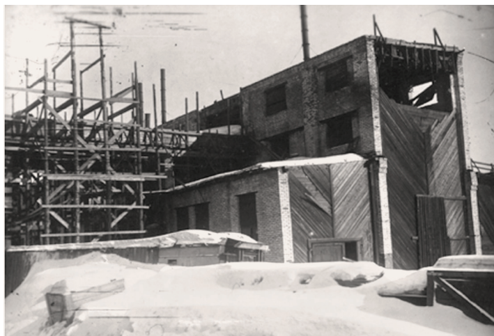
Строительство отделения шахтных печей. Зима 1942 г.
